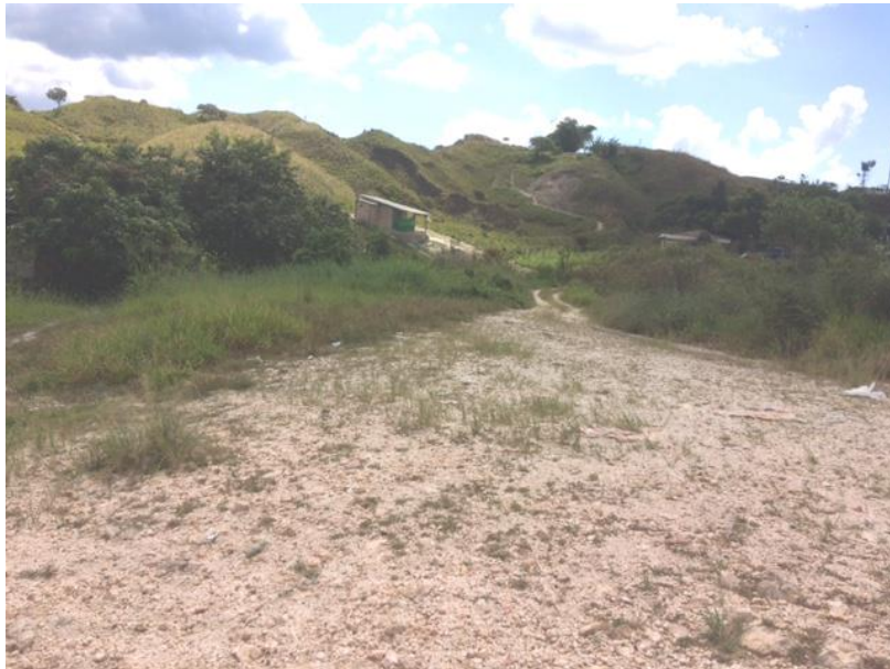
Figura 13: Bairro da Balança sem pavimentação em uma das vias de acesso. Fonte Instituto Amazônia, 2019.
